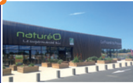
➤ Fournil et supermarché bio du Pressoir
